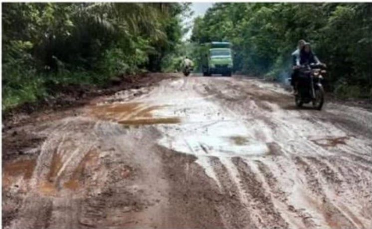
(Gambar 1. Kondisi Kerusakan Jalan di Kampung Bumi Harjo)
