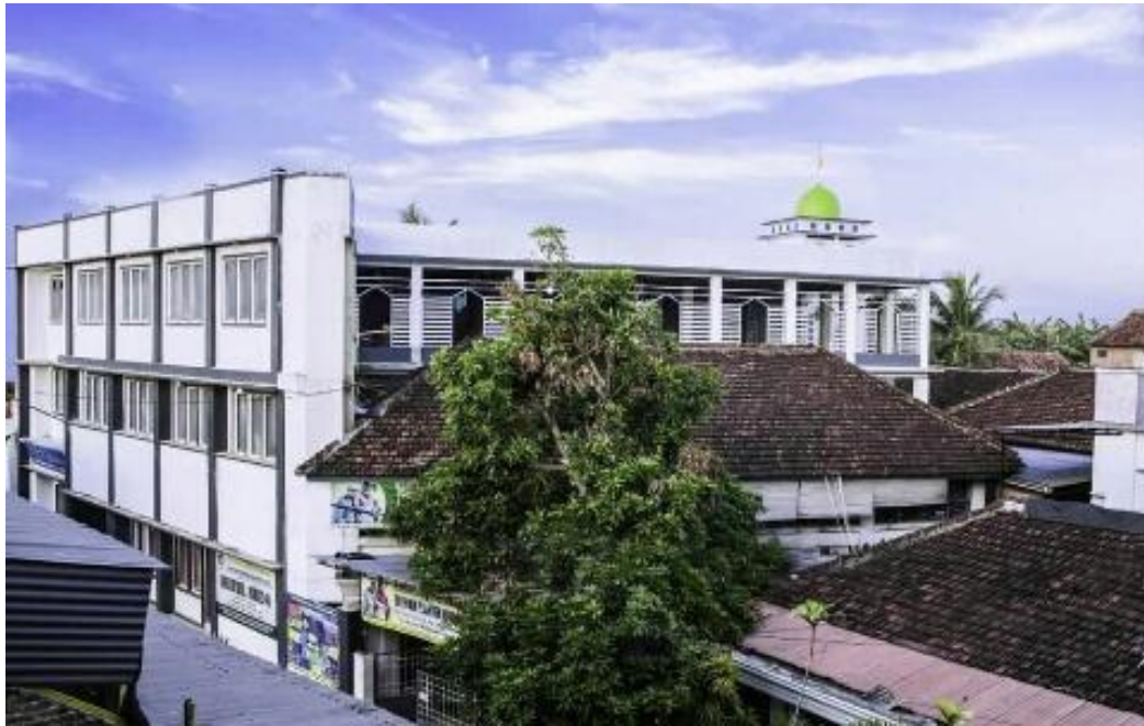
Gambar 1.1 Kondisi gedung Pondok Pesantren Nurul Huda Komplek Al-Fuadiyah Pringsewu.
