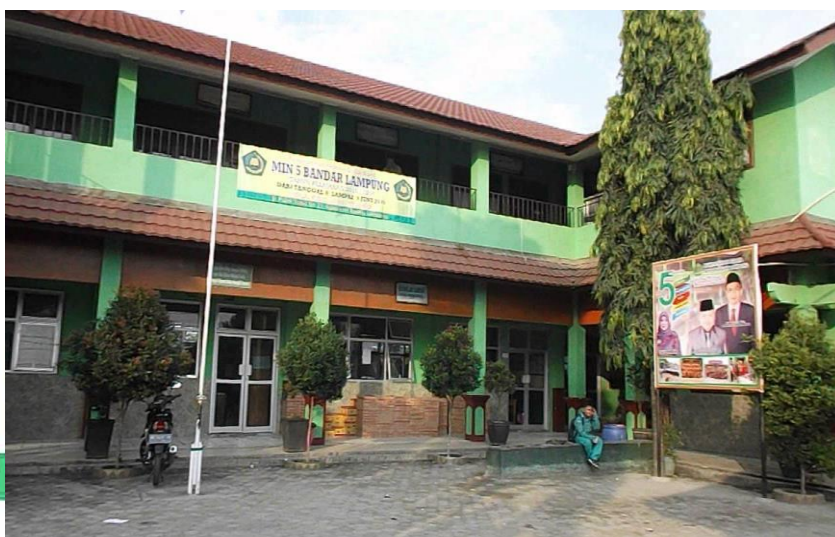
Kondisi Gedung Madrasah Ibtidaiyah Negeri 5 Bandar Lampung
