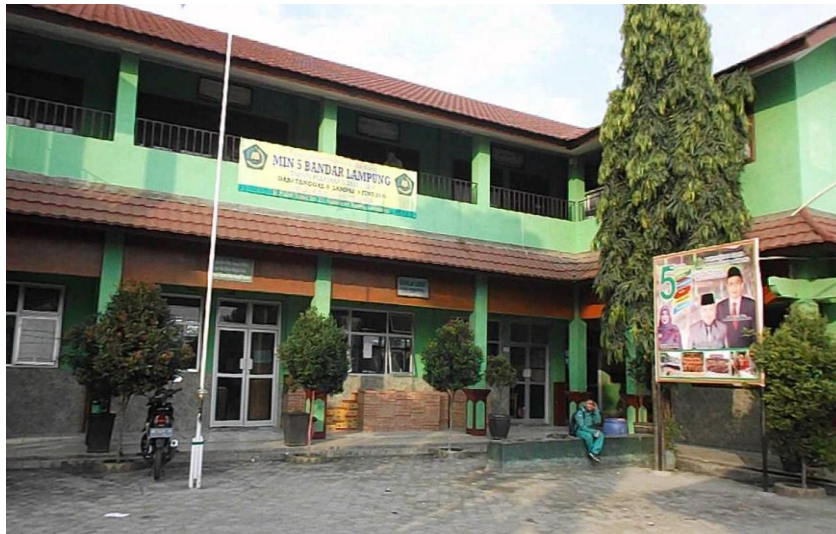
Kondisi Gedung Madrasah Ibtidaiyah Negeri 5 Bandar Lampung
