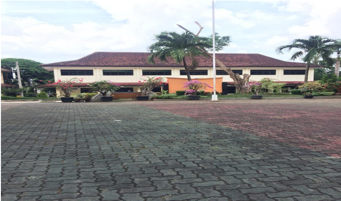
Gambar 1.6 Gedung Lab SMA Al-Kautsar Bandar Lampung
