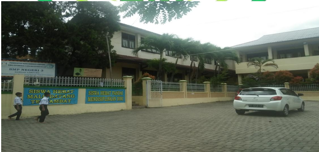
(Kondisi bangunan SMP Negeri 3 Bandar Lampung).
