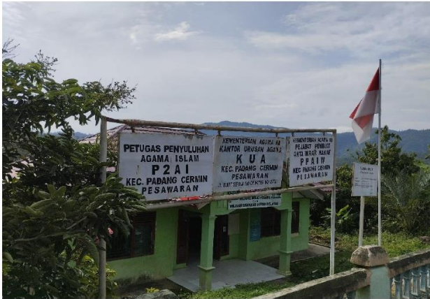
Dokumentasi lokasi KUA Kecamatan Padang Cermin
