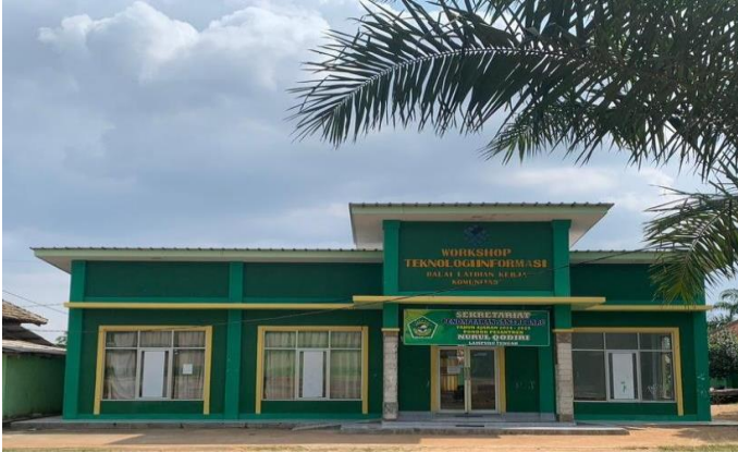
Ket. Gedung Kantor
