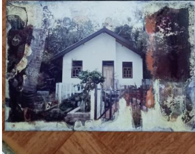
Gambar diatas. Proses renovasi bangunan makam keramat habib Muhammad Al – Athas
