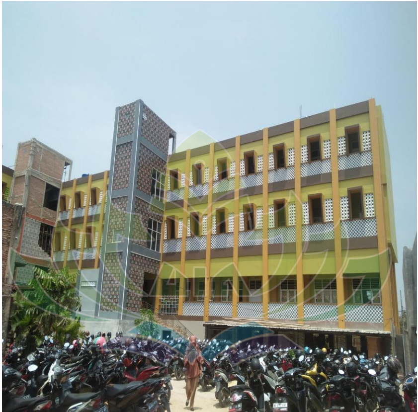
Gambar 1.1 Gedung Kelas SMA AL-Huda Jati Agung Lampung Selatan, pada tanggal 18 September 2023
