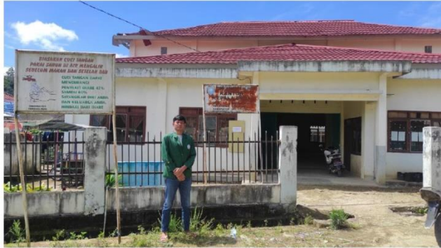
Foto 3: Foto balai desa simpang luas Kecamatan Sungai Are Kabupaten Oku Selatan.
