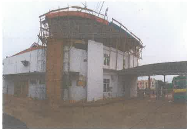
Proses Pembangunan Gedung Rumah Sakit YMC Bagian Depan Sebelah Timur
