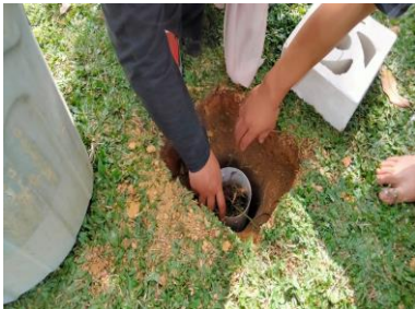
Proses Peletakan Paralon
