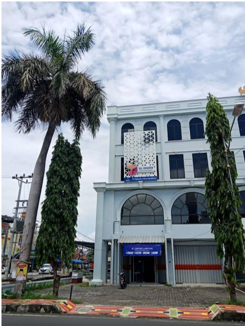
Gedung Kantor Center XL di Bandar Lampung
