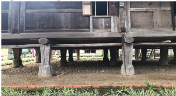
Gambar 2.6 Kolong Rumah (Bah Nuwo)
