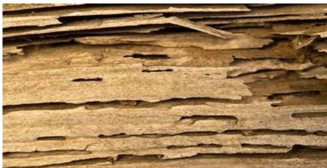
Gambar 2.3. Serangan Hama Rayap pada Kayu 55
